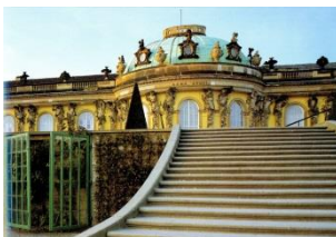
Рисунок 132. Дворец Сансуси в Подсдаме, Германия. Крыша купола дворца покрыта листовой медью
